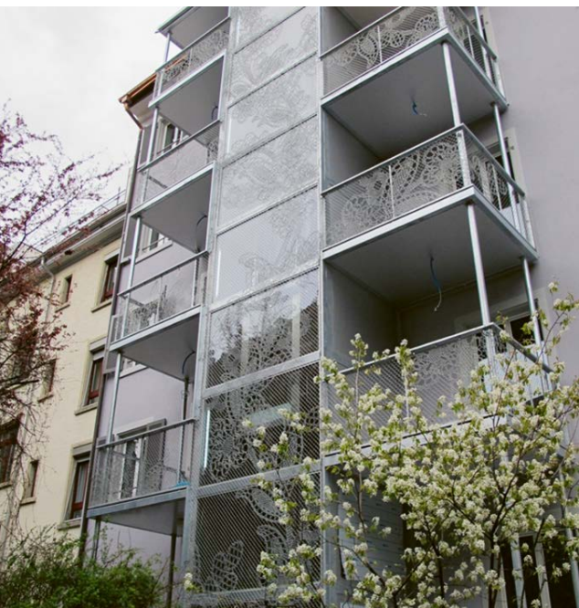
Nachträglicher Anbau eines Personenaufzugs an die Hausfassade. Bild Lift AG
