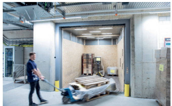
Das erste Hochregallager aus Holz wurde bei der Firma Sonepar Suisse AG in Wallisellen gebaut (Bild links).
