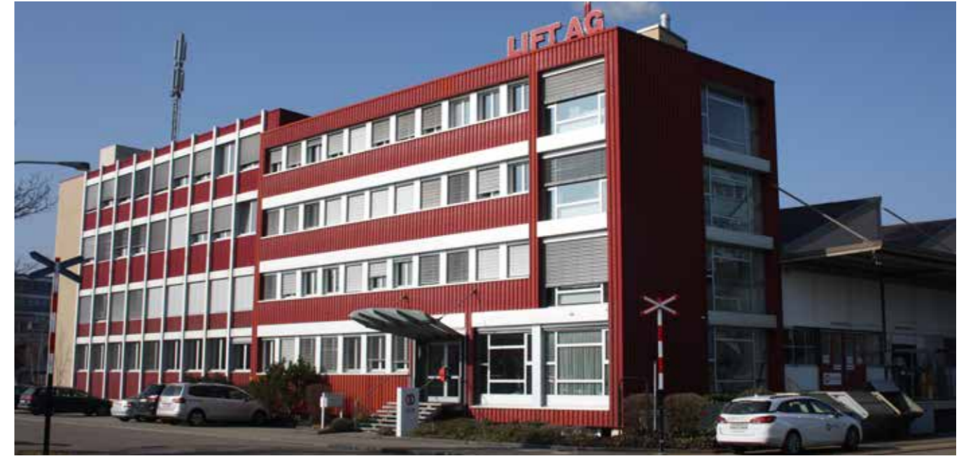
Planung, Konstruktion und Produktion der Liftanlagen erfolgt im Werk der Lift AG in Regensdorf.
